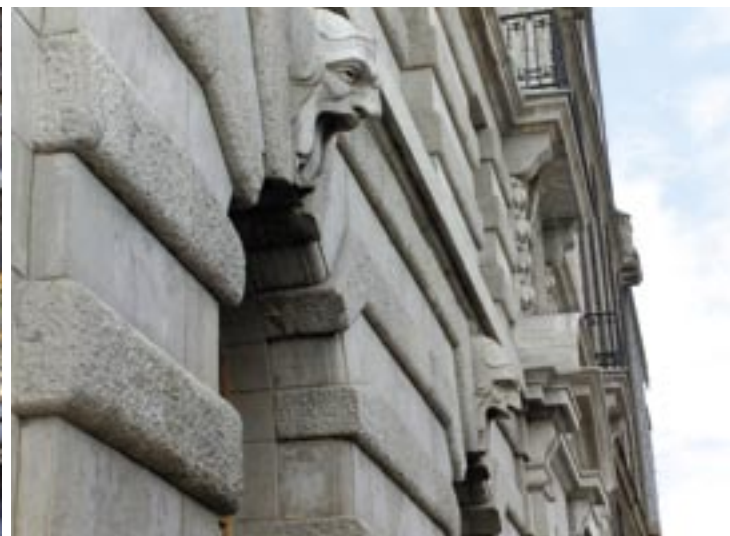
Die Fassade nach der Renovierung
