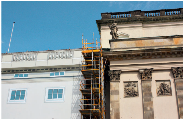
Sanierung der Staatsoper Unter den Linden, Foto: Akademie der Künste
